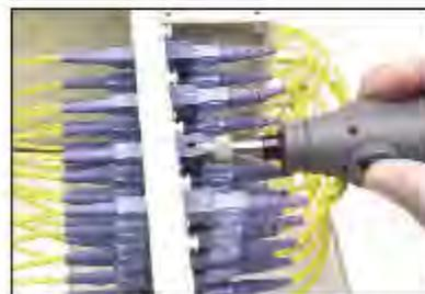
Inspección de separación de paneles de conexiones
